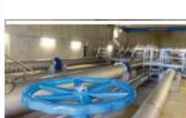
Die Wasserbehälter am Hungerberg (oben) und am Schaberg. Letzterer wird bis 2024 auf 620 Mio. Liter ausgebaut
