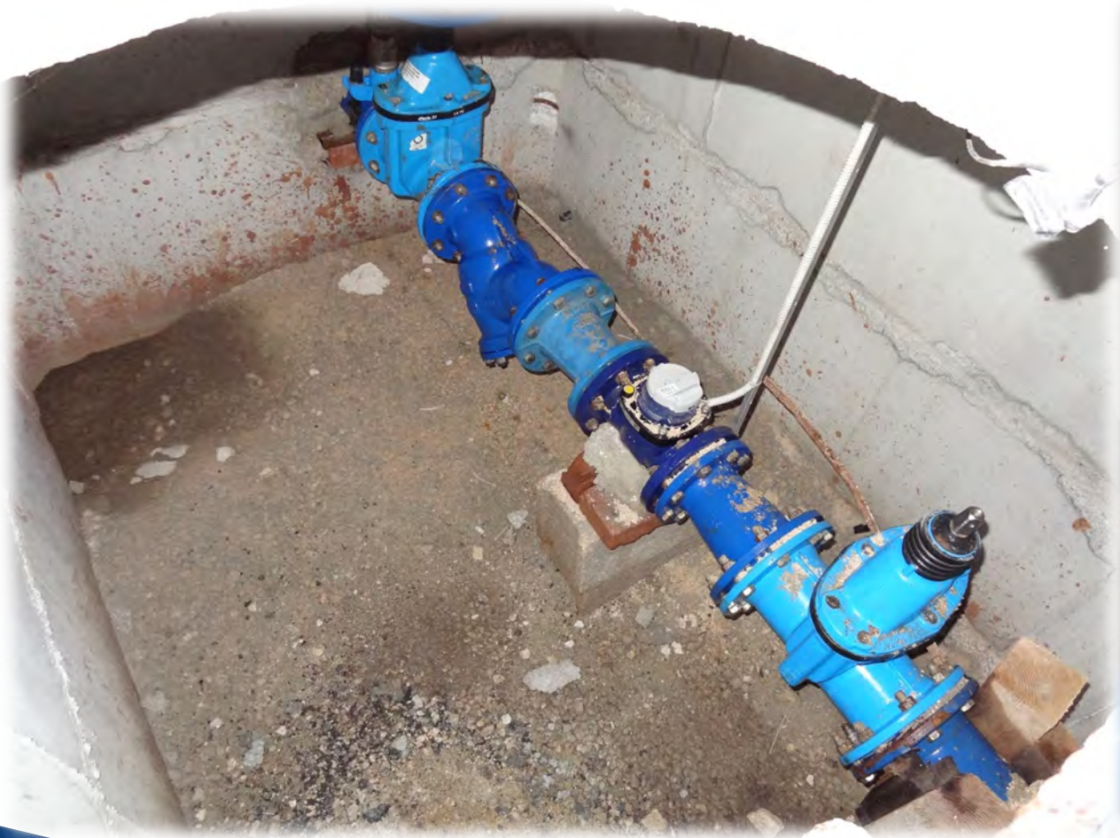
ugradnja na vodomjer
