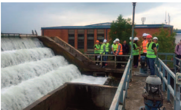
Wasseraufbereitungsanlage Albanik mit Ressourcen des Batllava-Sees – errichtet 1980, Leistung: 1.000 l/s
