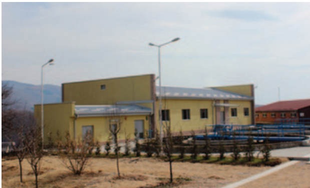
Wasseraufbereitungsanlage Badovc mit Ressourcen des Badovc-Sees – errichtet 1967, modernisiert 2017
